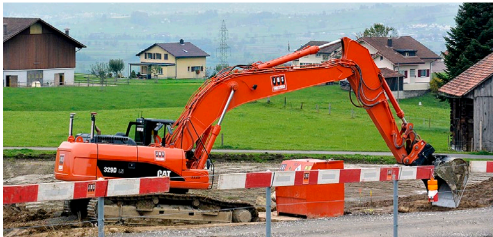
O sol nem sempre brilha nos estaleiros de obras suíços. Em caso de condições meteorológicas adversas e temperaturas frias, o trabalho pode ser interrompido. Foto: Colette Kalt
